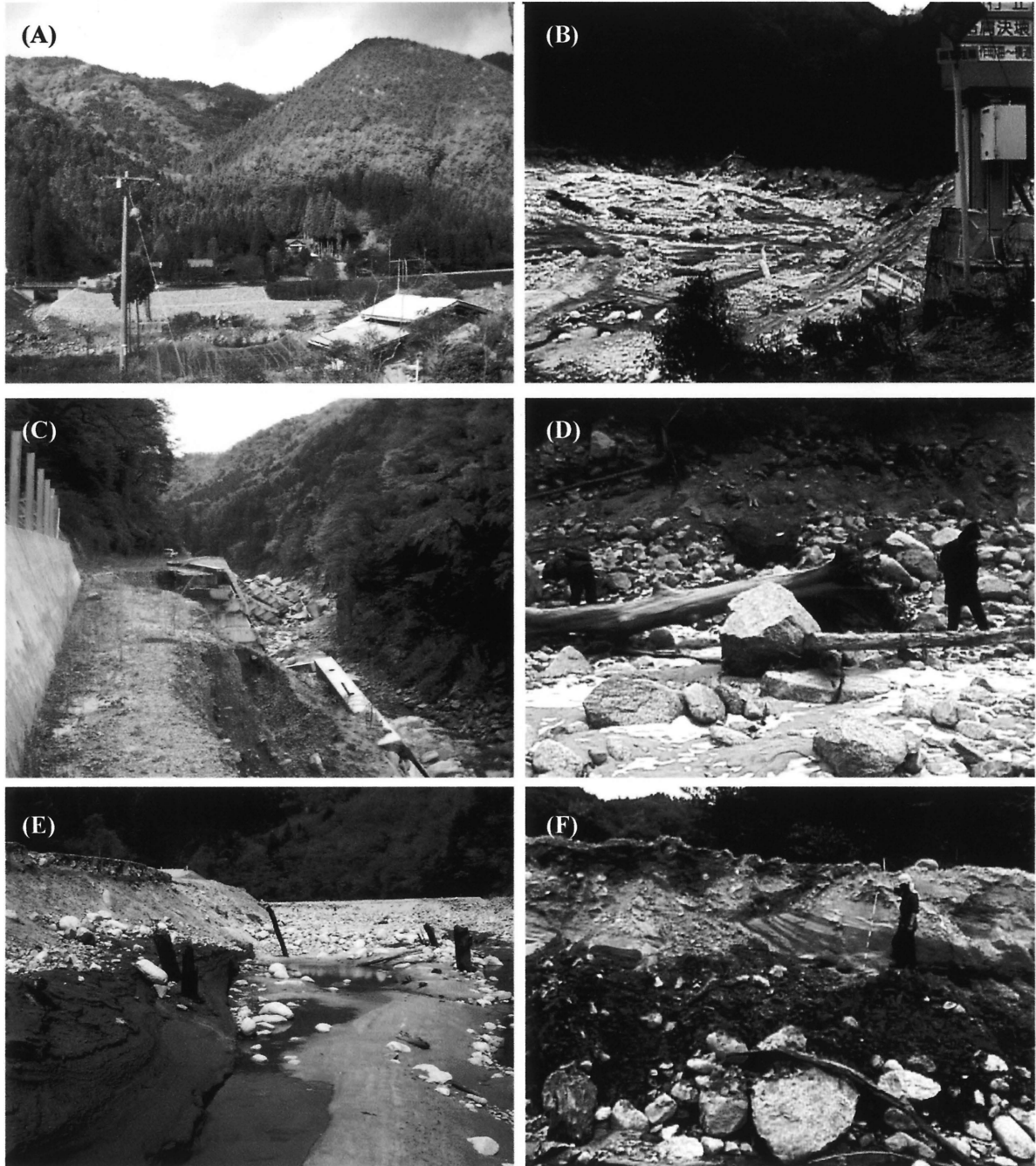
第2図. (A)「海」の集落。東北東-西南西に流れる上村川が県境になっていて、対岸(北)が岐阜県恵那郡上矢作町で手前が長野県下伊那郡平谷村である。写真右側が上流(2003年11月3日)。(B) 東海豪雨で崩壊した「海」の国道418号。道路情報板が(A)の橋の位置に設置されていた(2000年1月2日)。(C) 東海豪雨で崩壊した「あら」の国道418号(第1図の①地点で2003年11月3日)。(D) 洪水後の「海」の川原(第1図の③地点)に洗い出されて残っていた埋もれ木(手前の細かい材は洪水時の倒木)。埋もれ木は長さが約6mで、頂部は朽ちていた。後ろは国道418号が取り取られた部分。屈んだ人物の向こうにシルト層と段丘砂礫層が現われている(2000年1月2日)。(E)「海」の川原(第1図の④地点)に見られる埋もれ木の産出状況。シルト層に埋もれた部分は保存されているが、上位の砂礫層や砂層との境で朽ちて上には続かない。これは、立ち木を埋めたシルト層が、埋もれ木上端部まで浸食され、その後に砂礫層や砂層が堆積したことを示す(2005年5月2日)。(F)「海」の川原(第1図の⑤地点)においてシルト層を不整合に覆うラミナの発達した中一粗粒砂層(2000年1月2日)。
