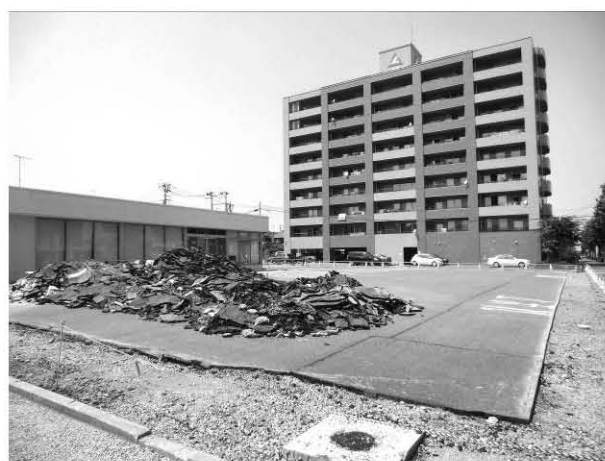
第7図 除染で剥ぎ取られたアスファルト(κ)―朝日1丁目―
