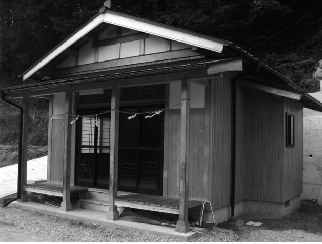
図 2A. 豊田市小手沢町の地藏堂 2010年5月竣工
